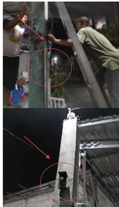
Gambar 4. Pemasangan Instalasi Alat deteksi Banjir
